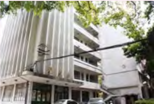
资助龙岩初中 30 万元维修科技楼（2013 年）
