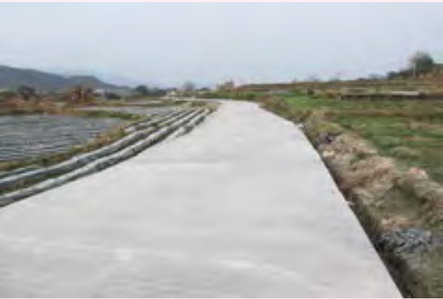
基金会资助武平县岩前镇大布村修建的村道（2014 年）
